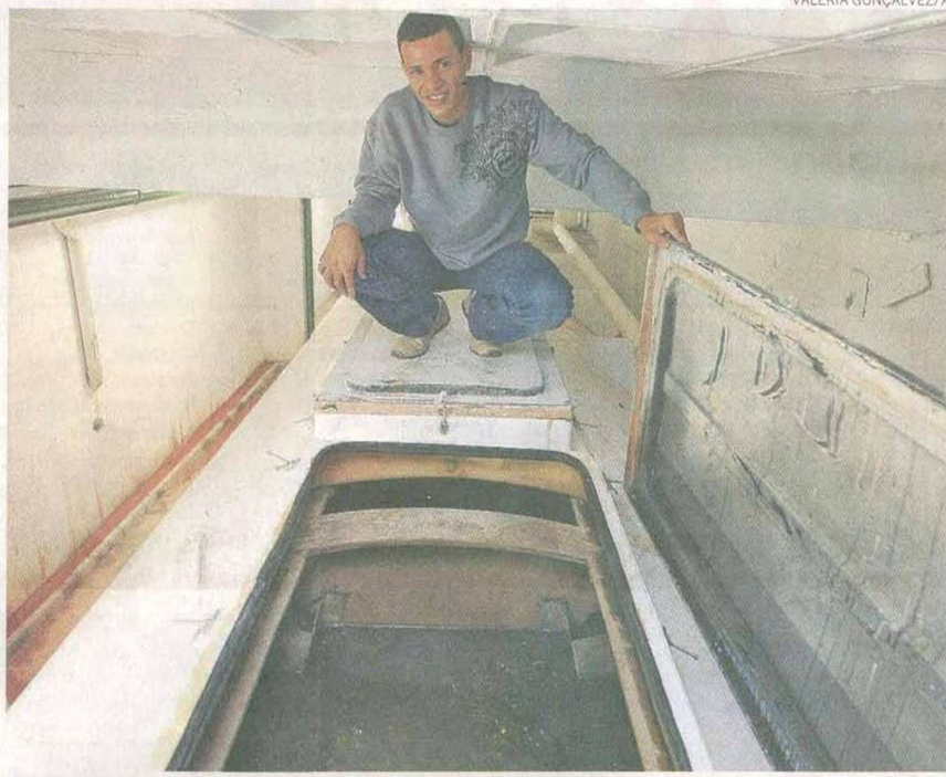
SISTEMA INSTALADO - No Ecolife, o técnico da Ecoesfera Rodrigo Santos mostra estação de tratamento
