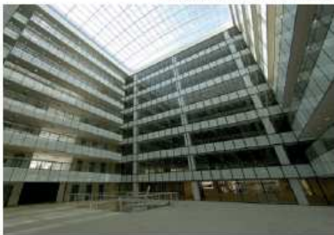
A clarabóia do Edifício Cidade Nova (RN) deixa a luz entrar, melhor uso de energia elétrica
